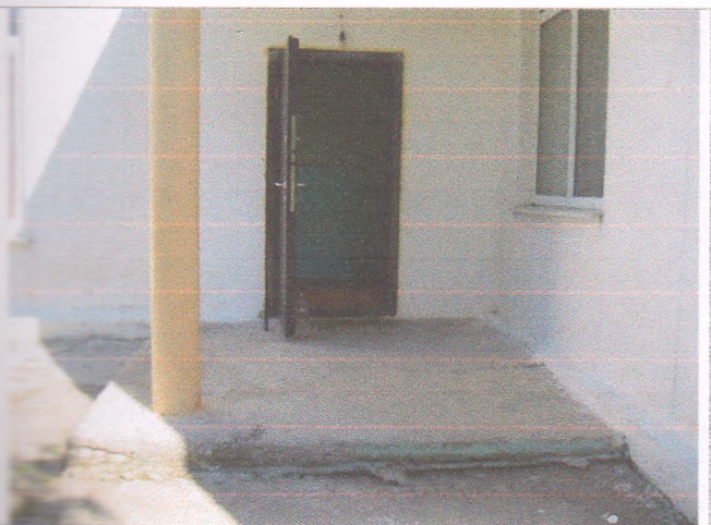
Фото №29 – Запасной выход здания «А»
