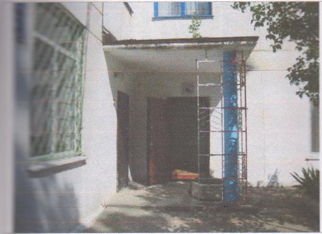
Фото №7 – вход в здание «А»( центральный)
