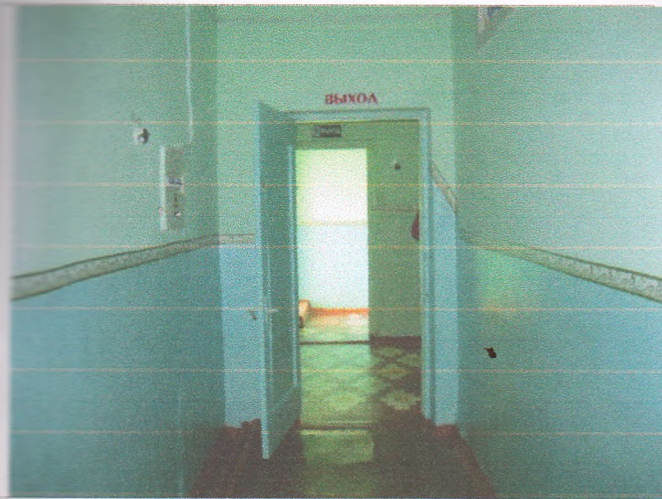
Фото №27 – Пути эвакуации
