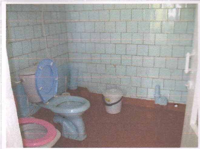
Фото №59 – Санитарно-гигиенические помещения
