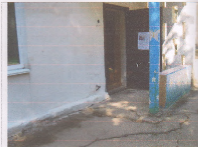
Фото №34 – Пути эвакуации
