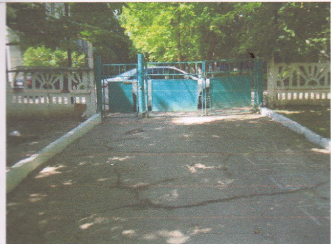
Фото №3 – Вход на территорию (со стороны водоканала)
